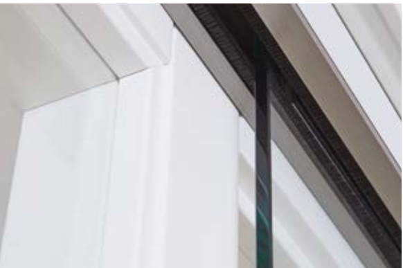
Befestigung einer Ganzglastür im Schiebetürbeschlag SLIM-Inlay
